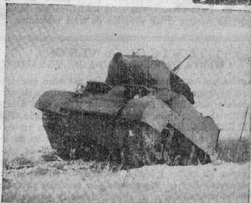
Esta es la nueva máquina de guerra que ha sido puesta a prueba en el campo de batalla por el ejército de los Estados Unidos. Denominada "M-8," la máquina está provista de un howitzer desmontable de 75 milímetros. Siendo un tanque ligero su misión es avanzar con las formaciones de tanques ligeros para aumentar el fuego de gran calibre en el propio frente de combate.
